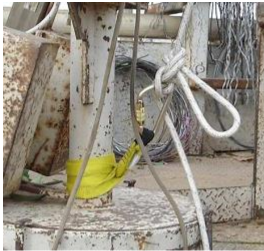
Figura 10 - Ponto de ancoragem
