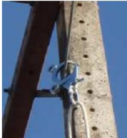
Figura 25 - Instalação do gancho na estrutura metálica do poste
