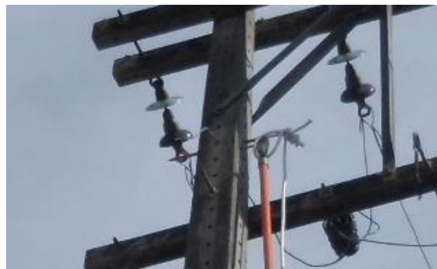
Figura 26 - Instalação do agulhão no poste
