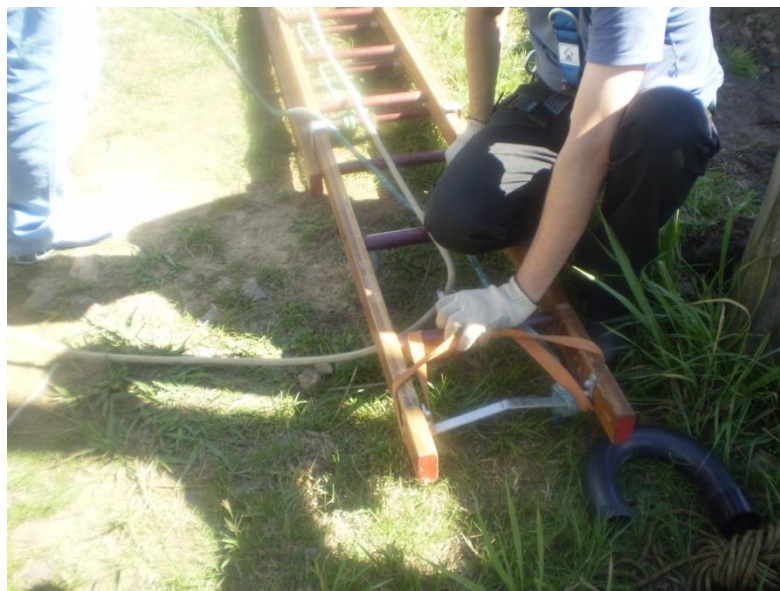
Figura 12 - Instalação da linha de vida
