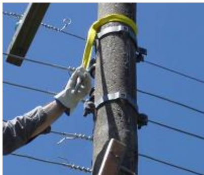
Figura 15 - Ancoragem com fita e mosquetão no poste
