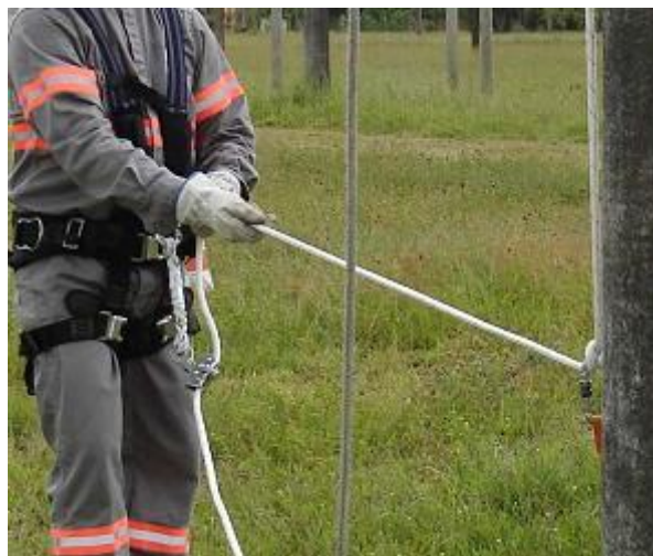
Figura 35 - Acionamento do nó de freio
