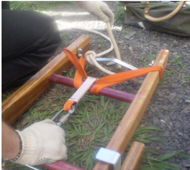
Figura 11 - Instalação do ponto de ancoragem
