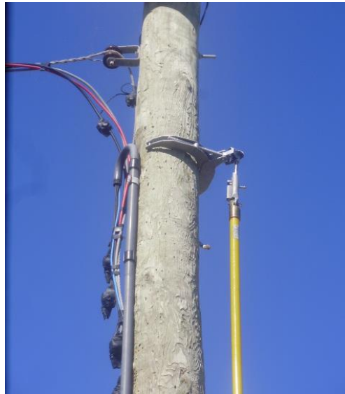
Figura 22 - Ancoragem da garra
