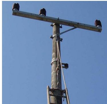
Figura 16 - Ancoragem na ferragem do poste
