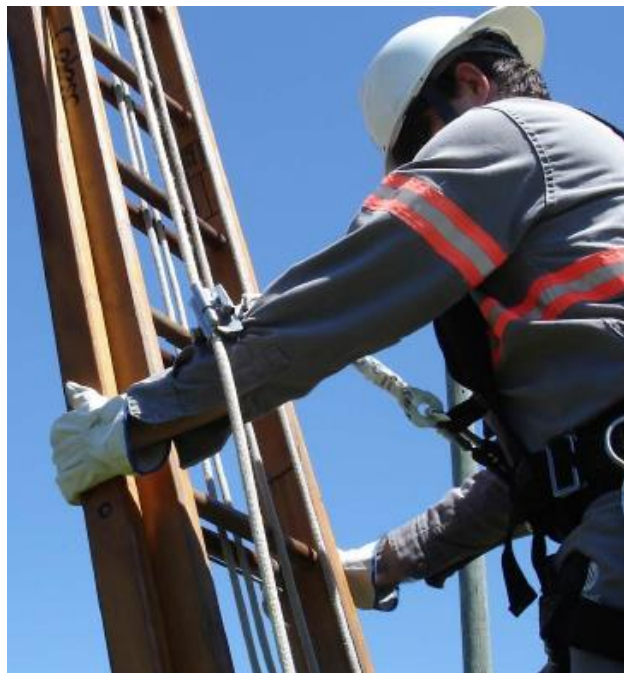
Figura 32 - Instalação do talabarte
