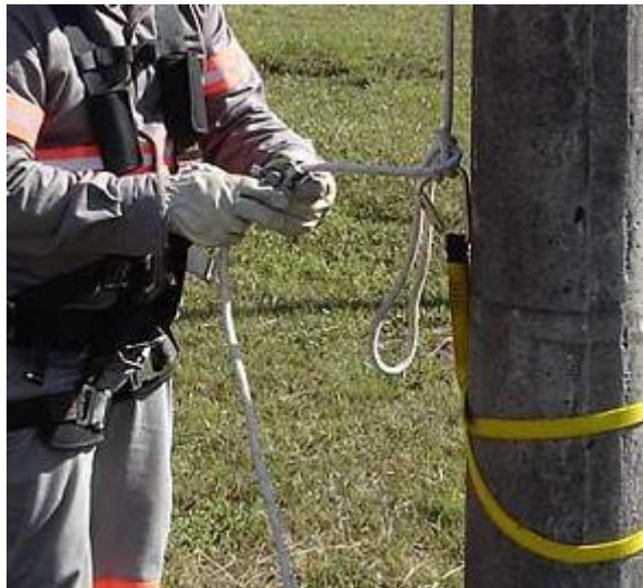
Figura 34 - Instalação do trava-quedas
